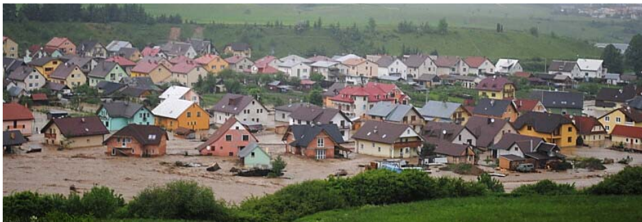
Obr. č. 2. Nevhodne umiestnené stavby v blízkosti vodných tokov. Kto dal súhlas na stavbu? Zdroj: http://www.staratura.sk/resources/App/201006101420160.stara_lubovna_povodne.jpg
