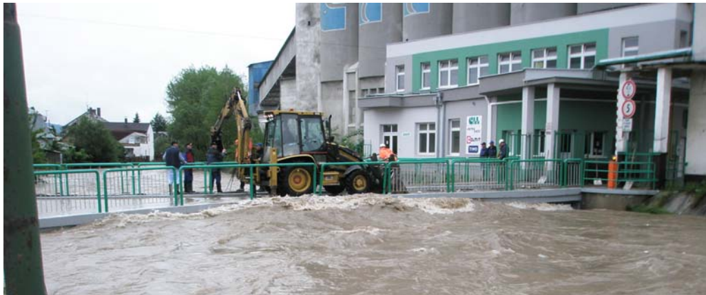
Obr. č. 4. Zaplavená obec ako dôsledok viacerých aktivovaných rizikových (krízových) činiteľov (prívalový dážď, umiestnenie stavby, neudržiavané koryto rieky, zlá konštrukcia mosta, ....).
