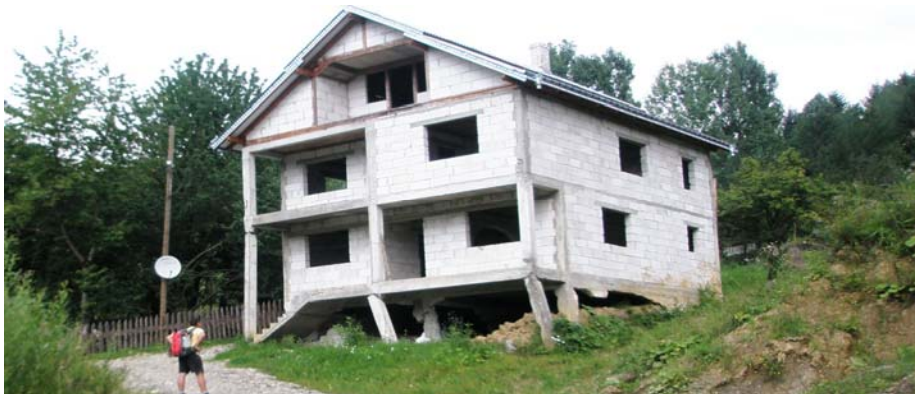
Obr. č. 3. Zle založený a umiestnený rodinný dom v zosuvu. Kto ho projektoval a povolil stavbu? Zdroj: Vlastná snímka.
